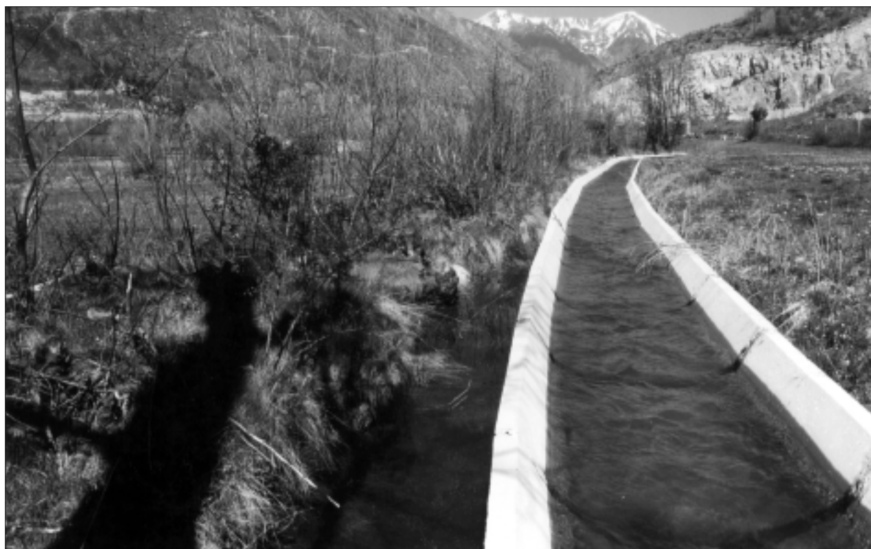
Fotografia 4. Vista del canal actual en el seu tram inicial.
