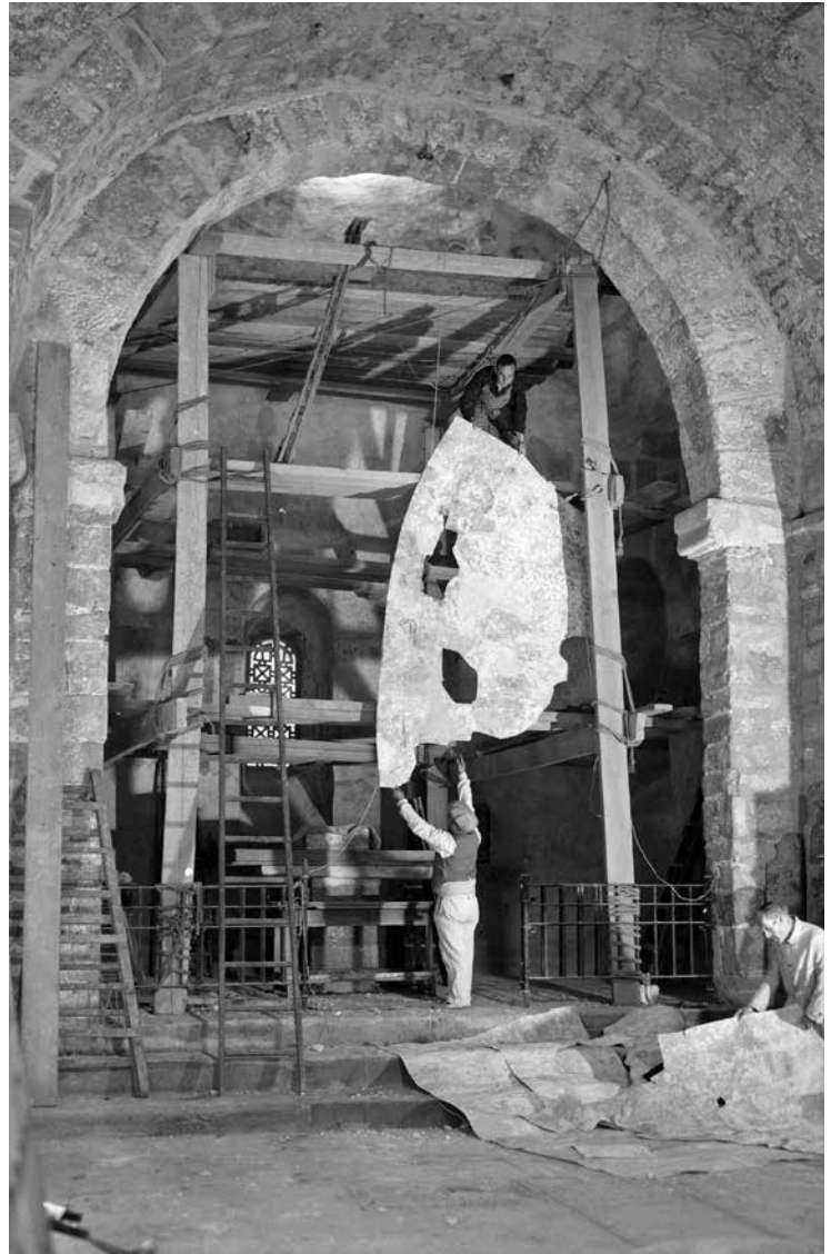
Figura 1. Procés d'arrencament de les pintures murals de l'absis de Santa Maria de Terrassa. © 2012 Institut Amatller d'Art Hispànic - im. 05103023 (foto Gudiol A-10877 / 1938).
