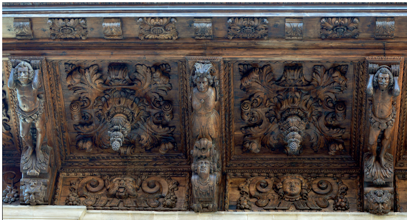
Figura 6. Vista parcial del voladís de Cort. Foto: C. Bauçà de Mirabò.
