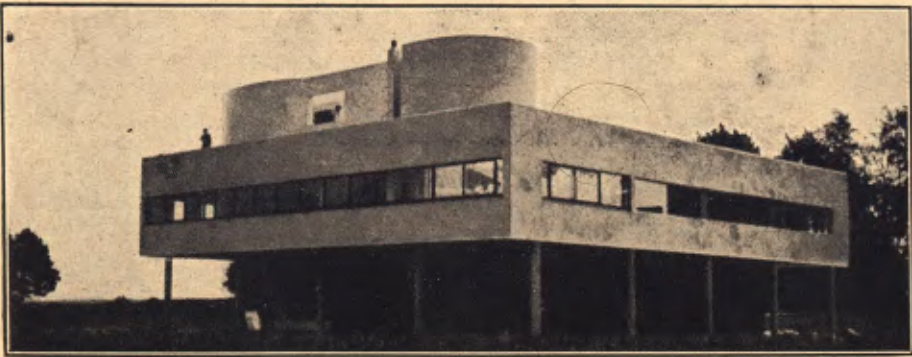
Façana nord de la casa Savoye
