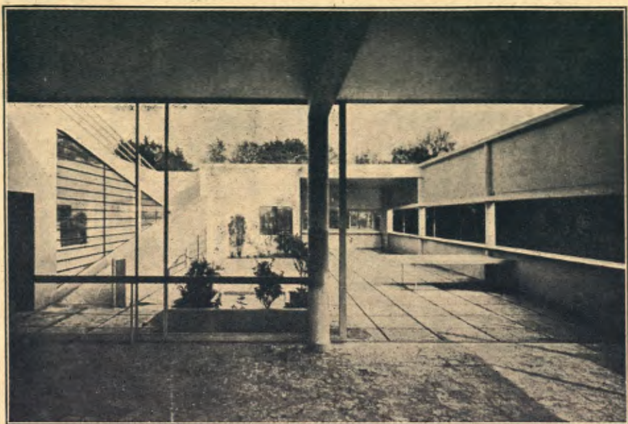
Jardí suspès de la casa Savoye, construïda a Poissy per Le Corbusier
