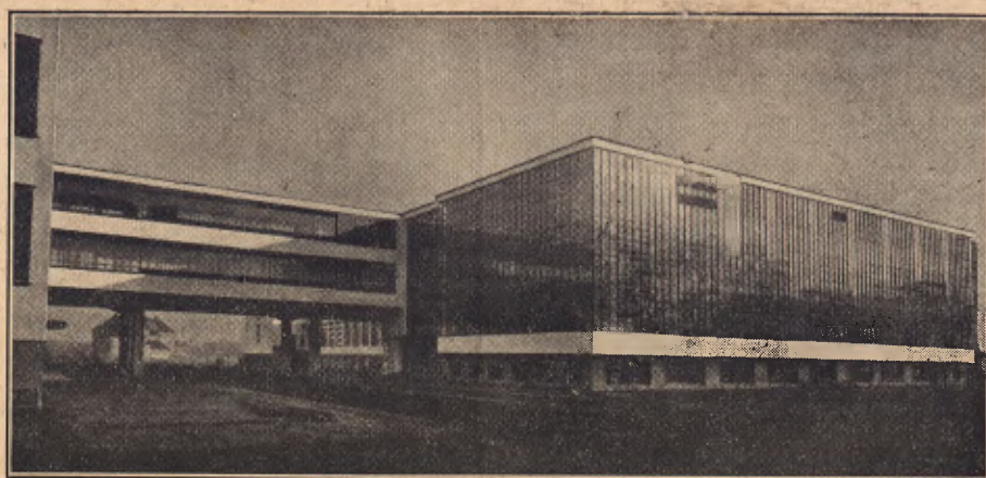
Bauhaus de Dessau (Gropius, arquitecte)
