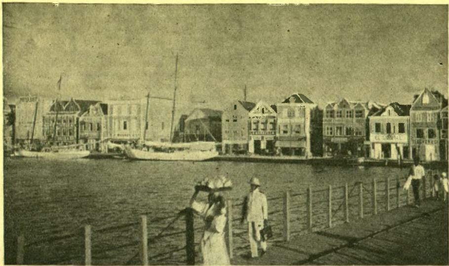
Curaçao — El pont de barques
