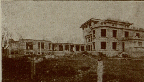
Grup escolar en construcció. Façana posterior
