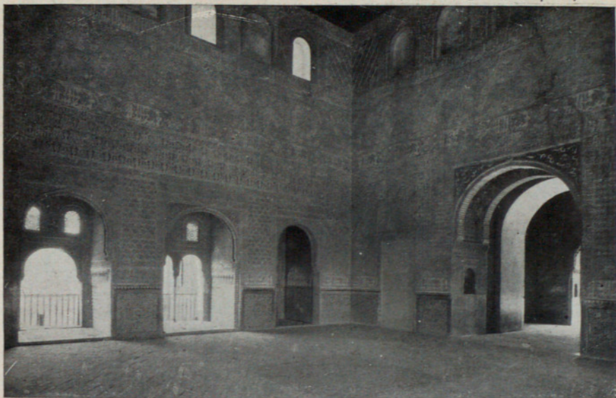
ÁNGULO SUDESTE DE LA SALA DE COMARES.
