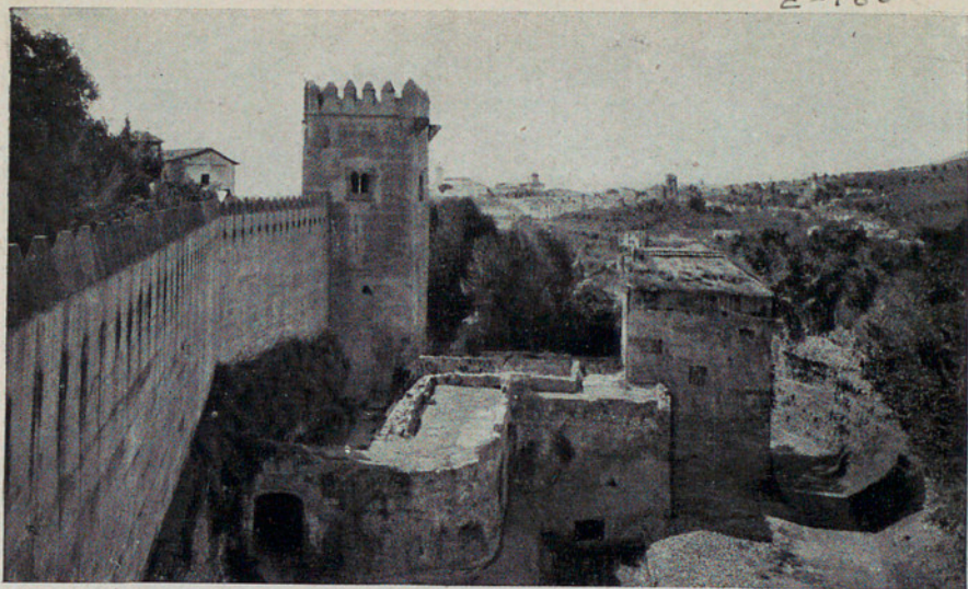
LA TORRE DE LOS PICOS Y EL BALUARTE INMEDIATO.
