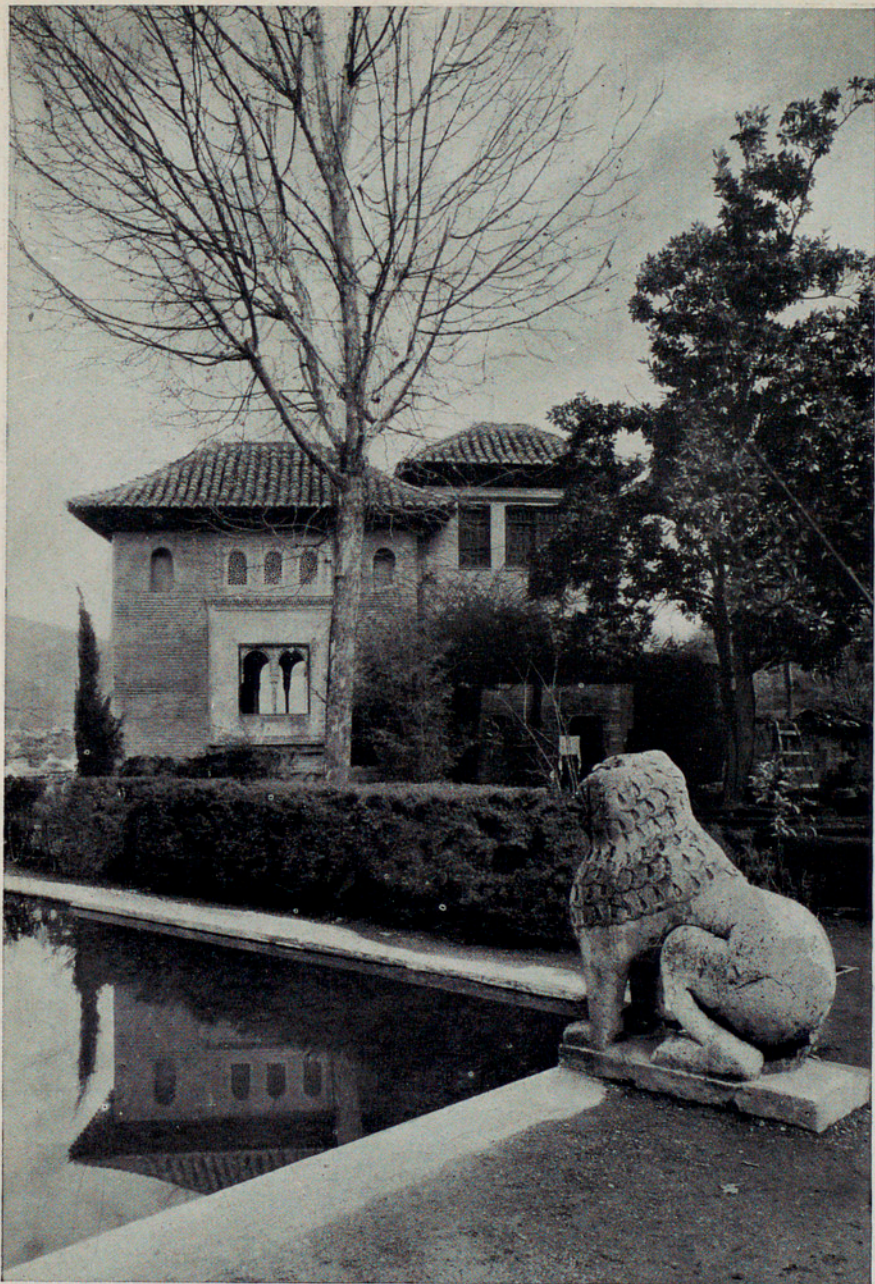
ORATORIO DEL PARTAL Y CASA DE ASTASIO DE BRACAMONTE.
