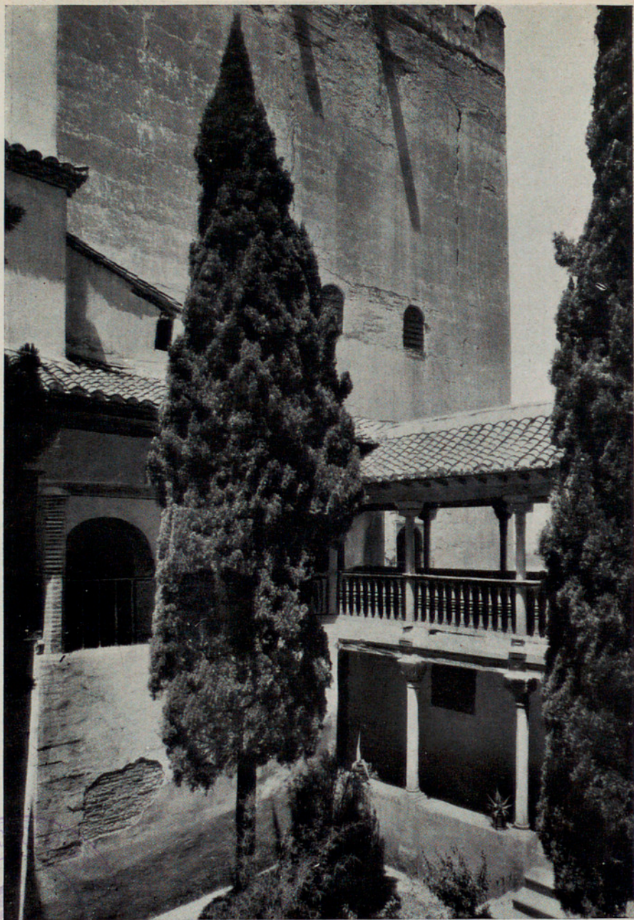
EL PATIO DE LA REJA, CON LA TORRE DE COMARES AL FONDO.
