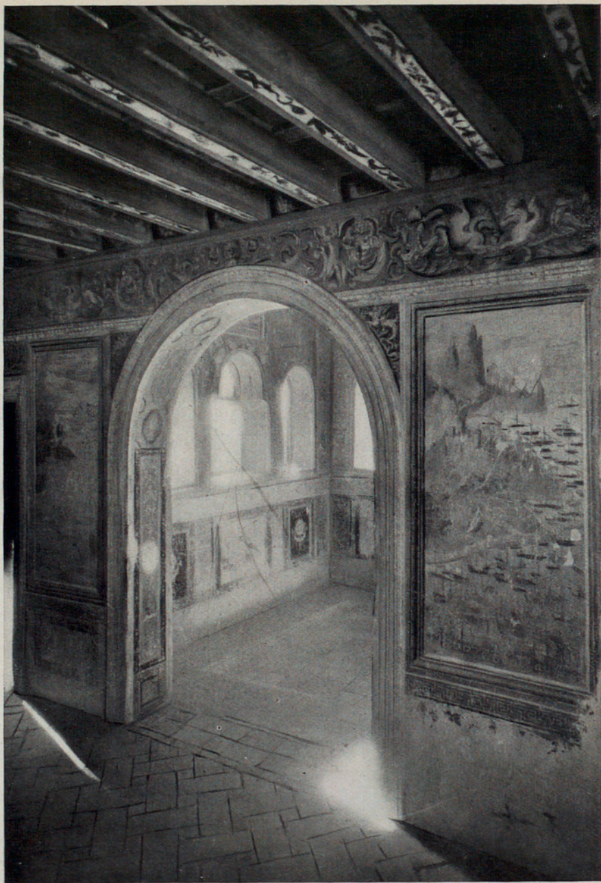
CUERPO ALTO DEL PEINADOR DE LA REINA, ANTES DE SU RESTAURACIÓN.
