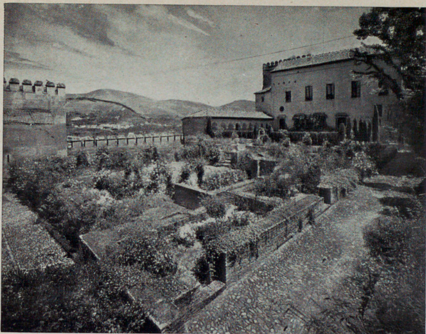
CIMIENTOS DE CONSTRUCCIONES EN EL INGRESO DE LA CASA REAL VIEJA.
