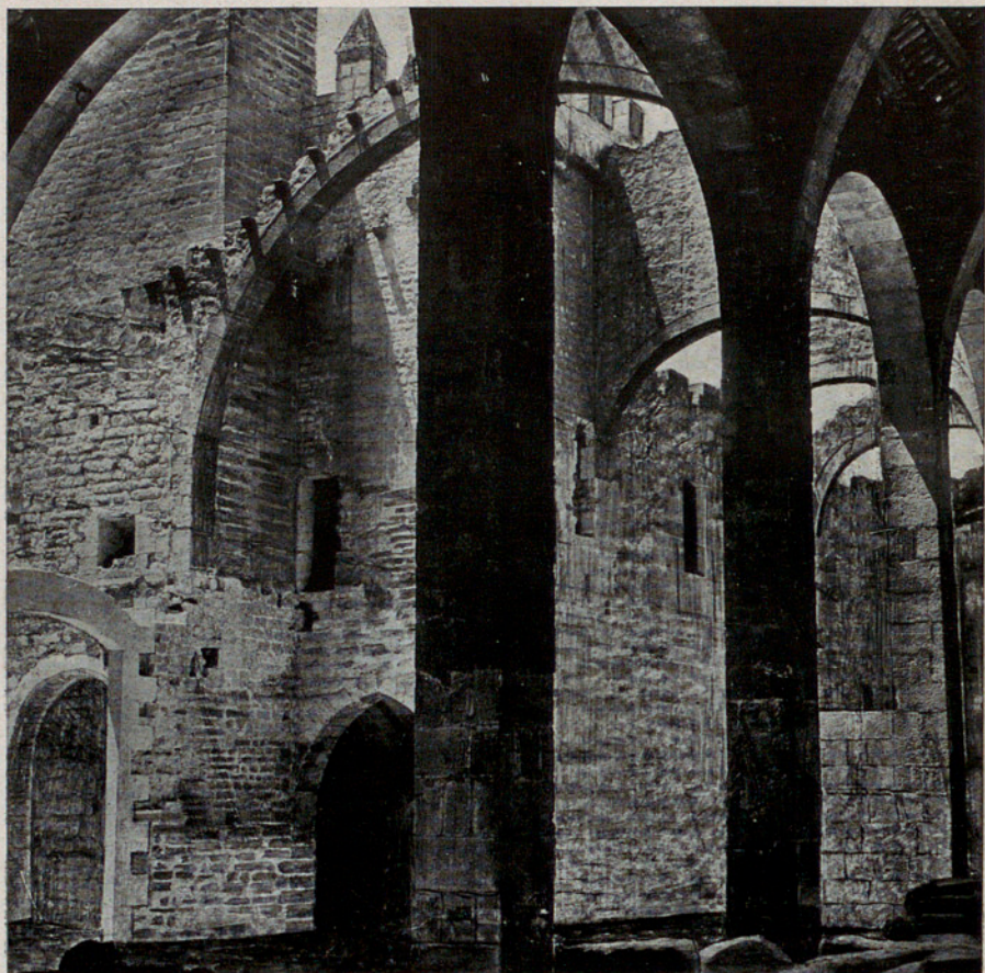
NAVE PRINCIPAL DE LAS ATARAZANAS DURANTE SU RESTAURACIÓN.
