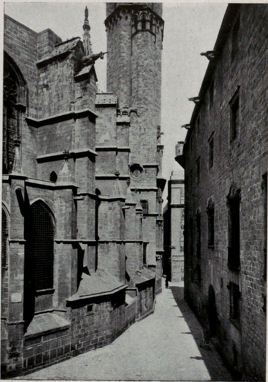
CABECERA DE LA CATEDRAL Y CALLE DE LOS CONDES.
