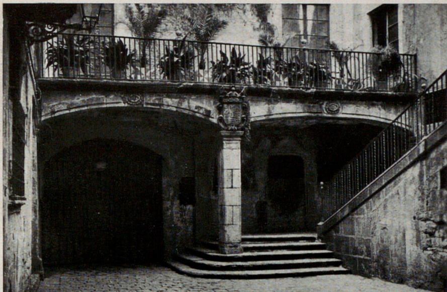
UN DETALLE DEL PATIO EN LA CASA DEL MARQUÉS DE LLIÓ.
