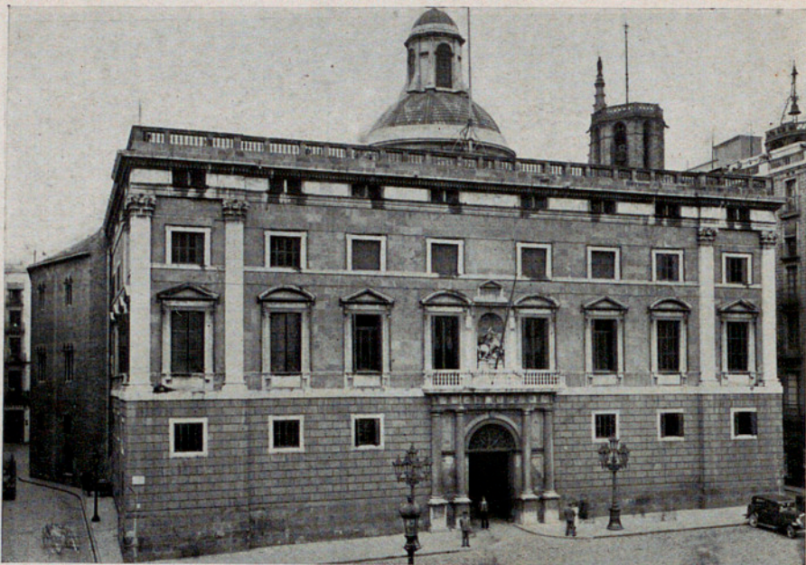
FACHADA DE LA DIPUTACIÓN A LA PLAZA DE SAN JAIME.
