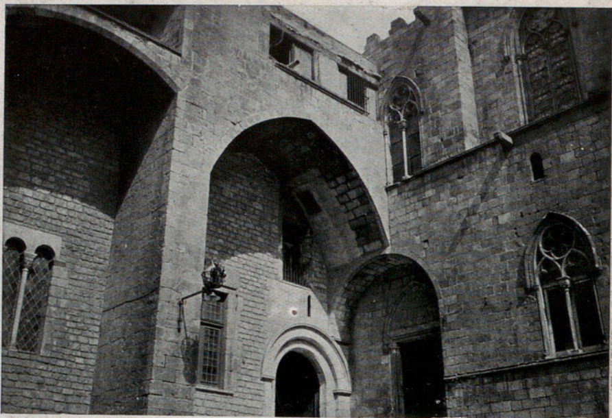
UN ÁNGULO DE LA PLAZA DEL REY. LAS PUERTAS DE INGRESO A LA ANTECÁMARA Y CAPILLA REALES.
