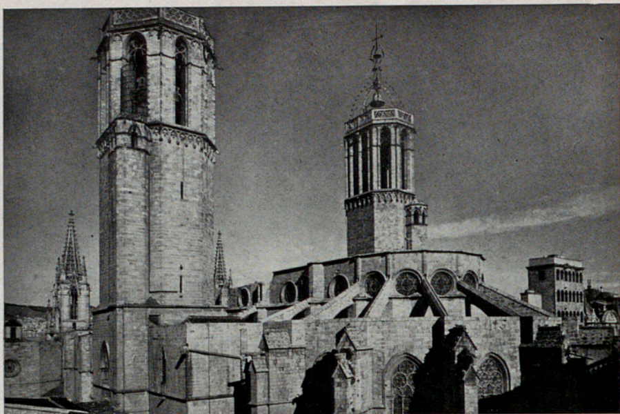
CATEDRAL. AZOTEA Y CAMPANARIOS.
