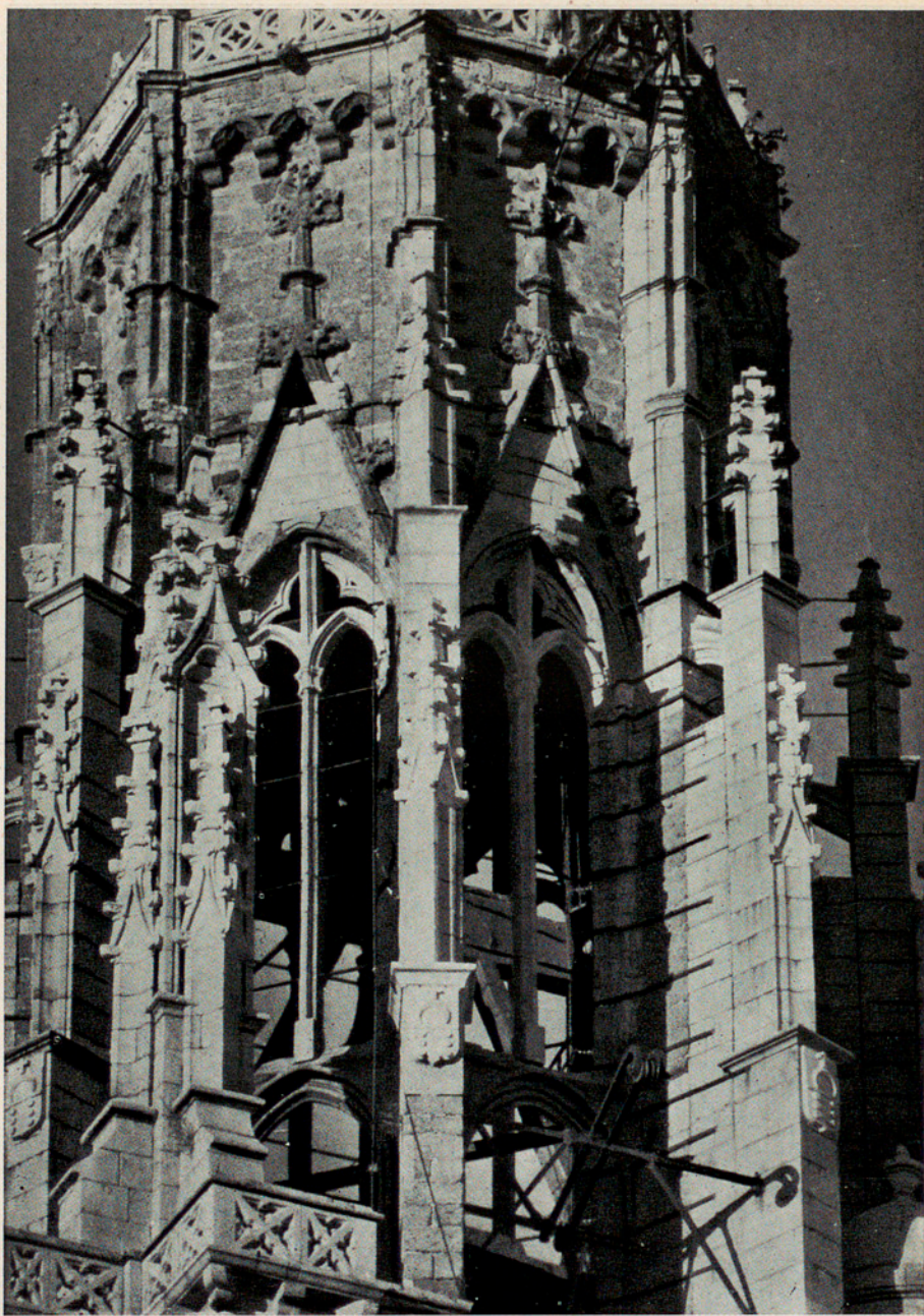
DETALLE DEL CALADO TERMINAL DE LA TORRE, UNO DE LOS CONJUNTOS MÁS AÉREOS Y GRACIOSOS DE LA PRIMADA.
