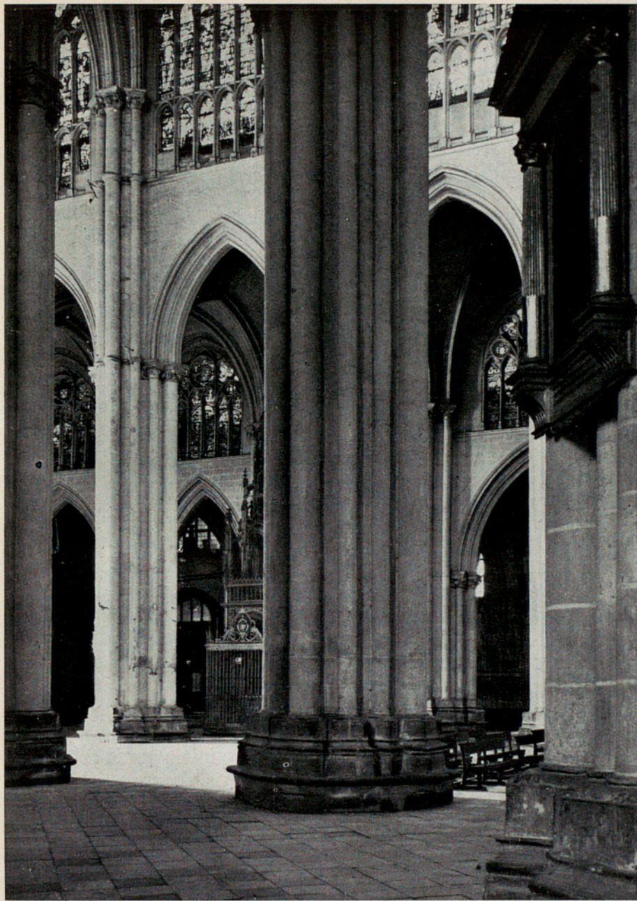
ÁPLOMO Y VERTICALIDAD DE PILARES EN EL INTERIOR DE LA CATEDRAL.
