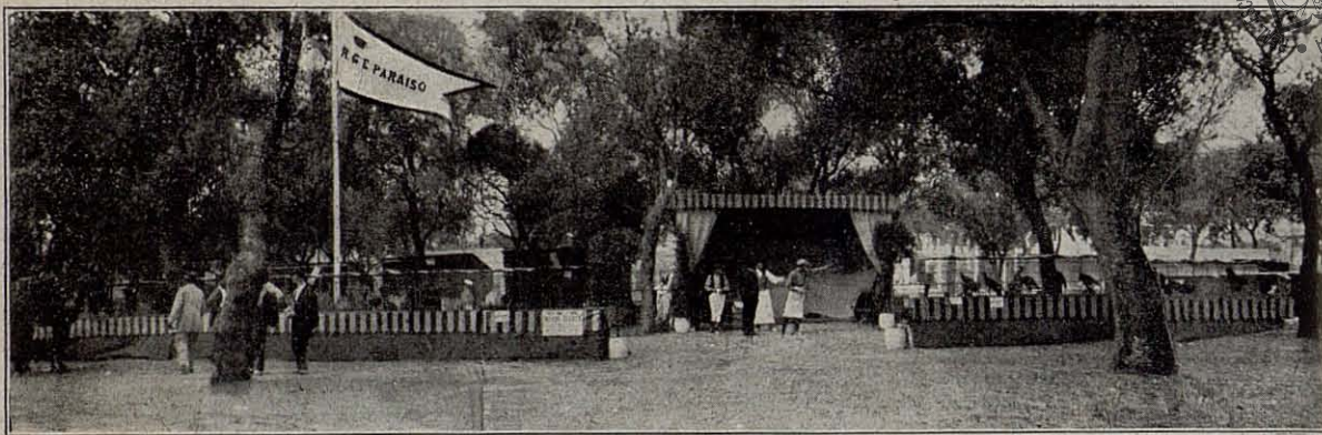
Aspecto general de las instalaciones de la Real Granja-Escuela de Avicultura «Paraíso» de Arenys de Mar
