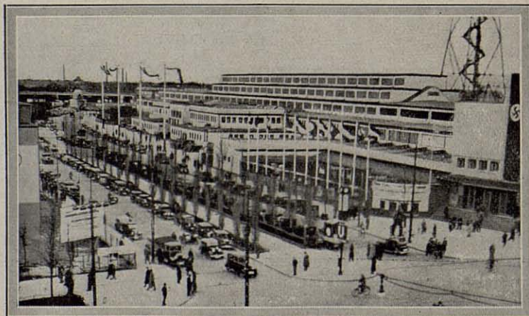
Edificios en los que tendrán cabida los Stands nacionales e industriales, indicados con flecha en la foto central.
