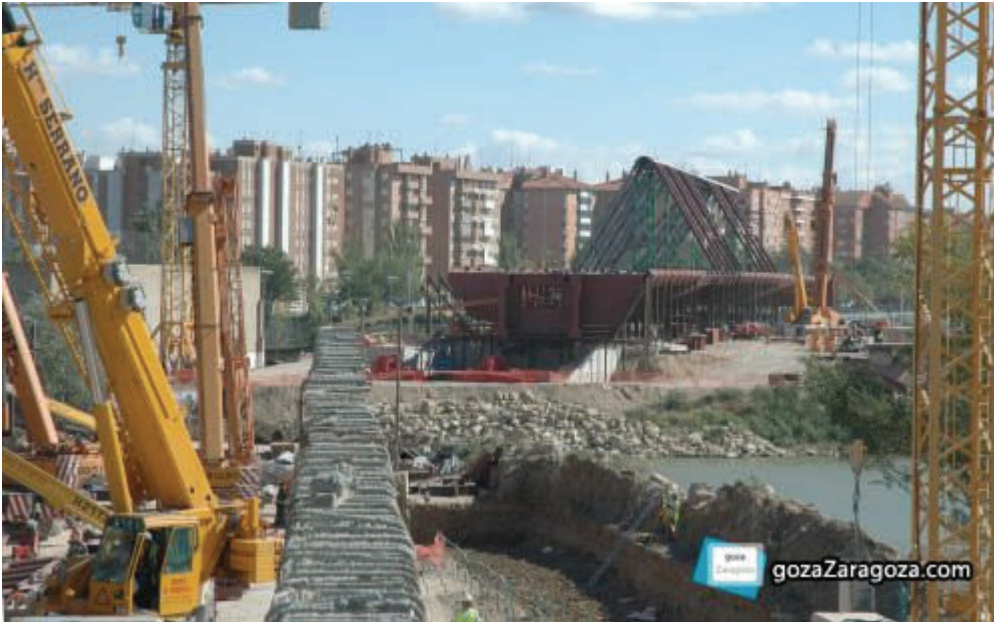
Obras del Pabellón Puente sobre el río Ebro, Ana Garín.
