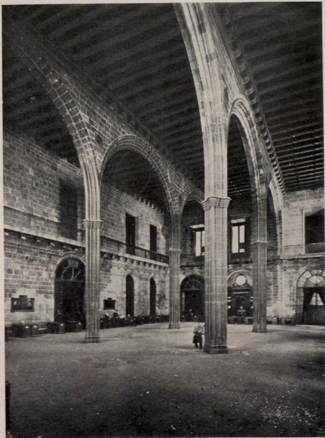
LA LONJA. SALA DE CONTRATACIONES (S. XIV). LA "LONJA". ANCIENNE SALLE DES TRANSACTIONS (S. XIV). THE STOCK EXCHANGE. HALL OF TRANSACTIONS.
