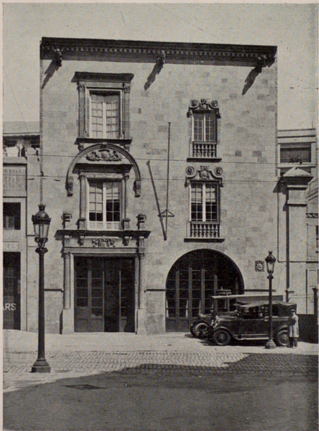
CASA GREMIAL DE LOS CALDEREROS. MAISON DES CHAUDRONNIERS. BUILDING OF THE BOILERMAKERS GUILD.
