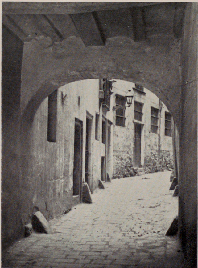
CALLE DEL ARCO "DELS JUEUS". RUE DE L'ARC DES JUIFS. JEW'S ARCHWAY STREET.
