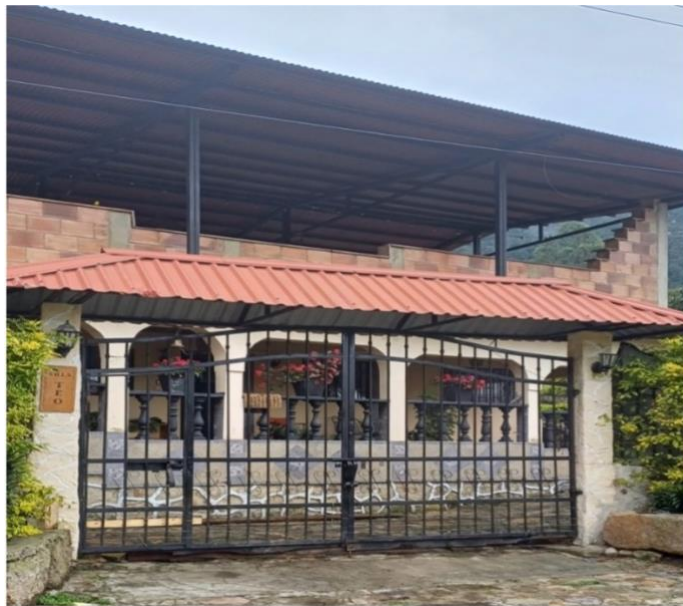
Figura 12: Casa reformada recientemente. Paredes de bareque. Blanca Ysabel Daza, 2024.
