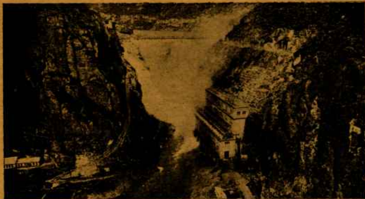
La presa de Capdella
