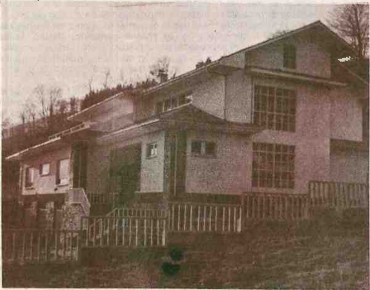
Hospitalillo de Tineo: construido hace dos años, funciona al 5 % de sus posibilidades. Ahora servirá de vivienda para la Policía Armada
