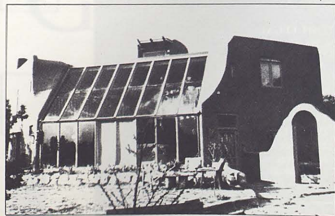
Sistemes de captació en la casa solar Balcomb Font 46
