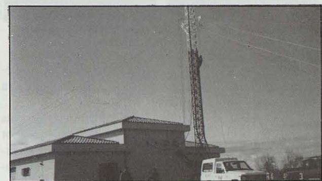
Vista parcial del Centre Emissor d'Alpicat
