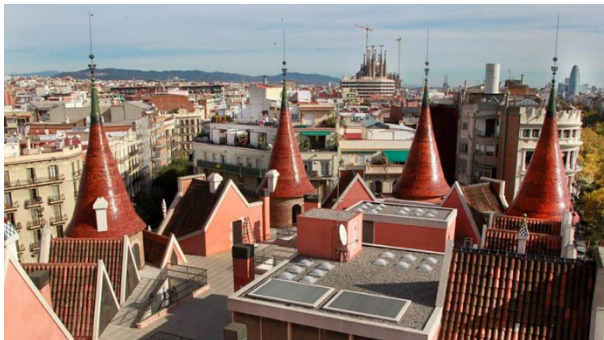
Diversos parallamps a la Casa de les Punxes, obra de Puig i Cadafalch, a Barcelona (La Vanguardia)
