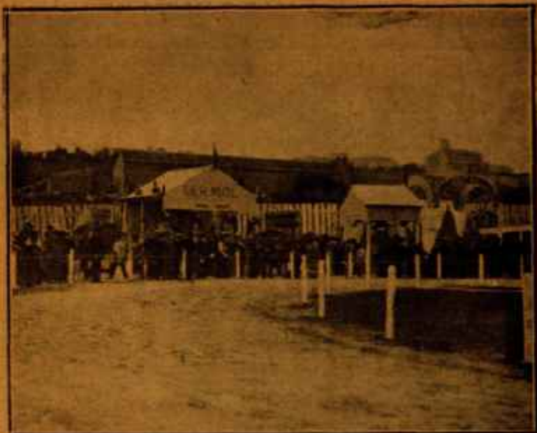
Fig. 19.- Instalaciones del Germol y el Zotal
