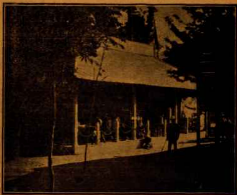
Fig. 20.- Instalación de los hermanos Metzger
