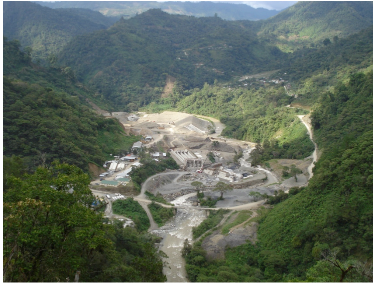
Figura 2. Fotografía aérea de la planta hidroeléctrica de Xacbal en construcción
