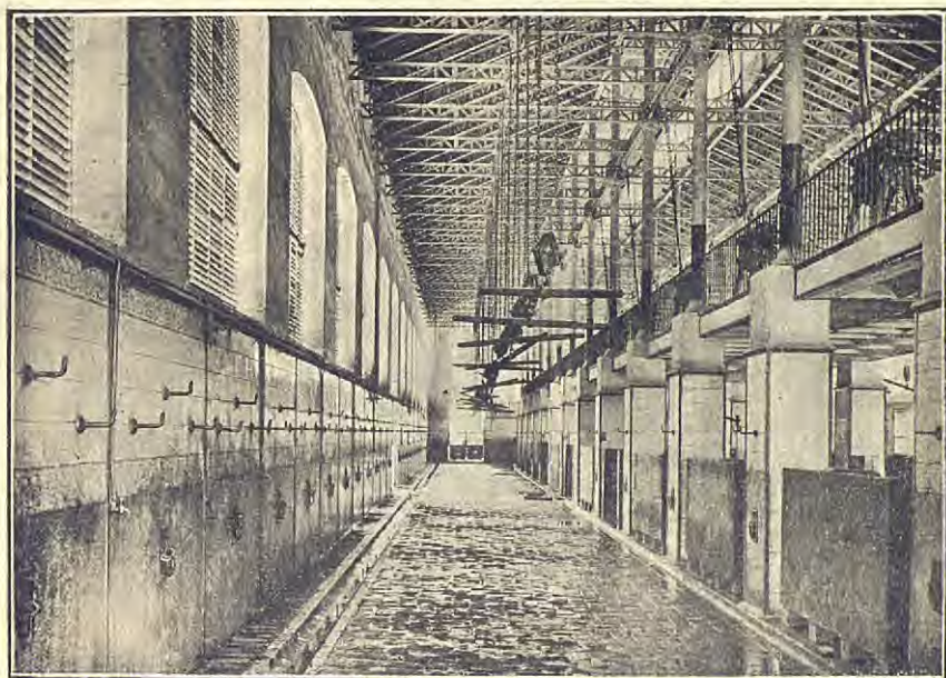
Matadero general de Valencia.—Una sección de la nave de ganado vacuno
