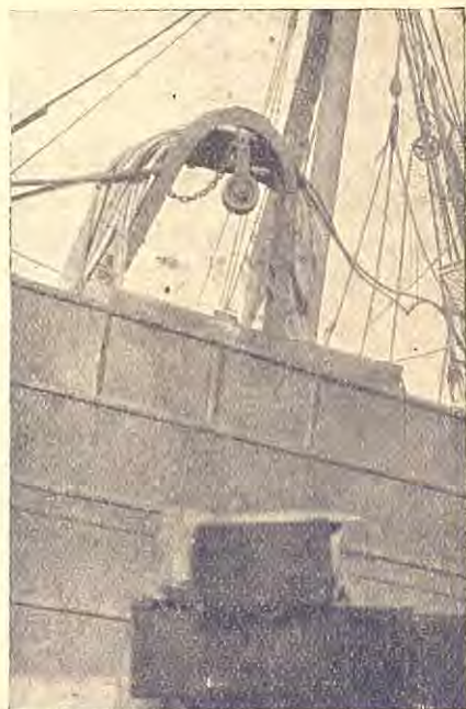
Fig. 1. — Polea por la que se desliza el cable que sujeta la red.
