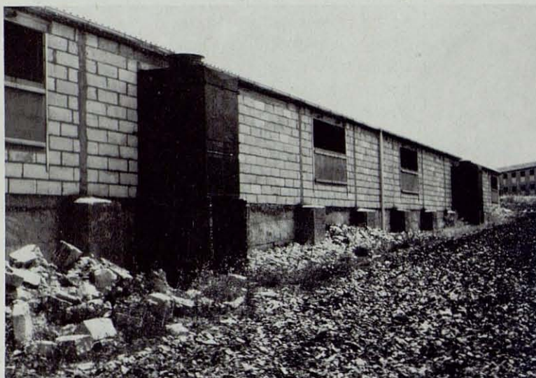
Disposición exterior de los acondicionadores ambientales en la granja de D. José Ferrer, en Sant Guim (Lleida).
