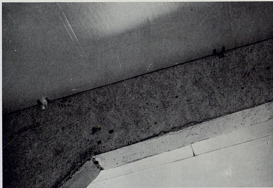
La limpieza y facilidad de colocación es visible hasta en los lugares tradicionalmente más difíciles. El sistema de grapas así como el machihembrado posibilita estos acabados.
