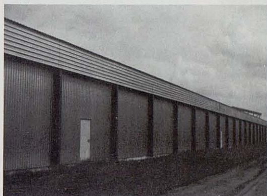
Vista exterior de la nave.
