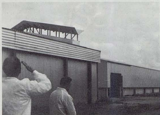
A la izquierda, el extremo del gallinero con la abertura para la salida del aire. A la derecha, el almacén para la gallinaza.
