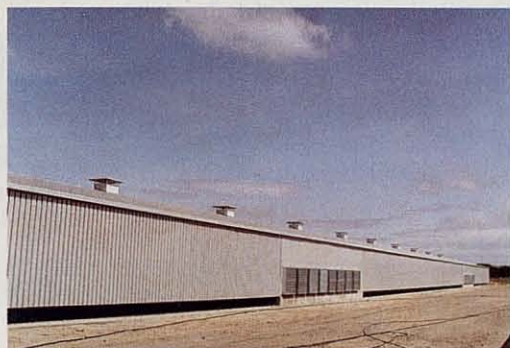
La nueva nave recién inaugurada.
