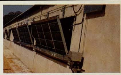
Abierto. Refrigeración por extracción con paneles abatibles de apertura automática.
