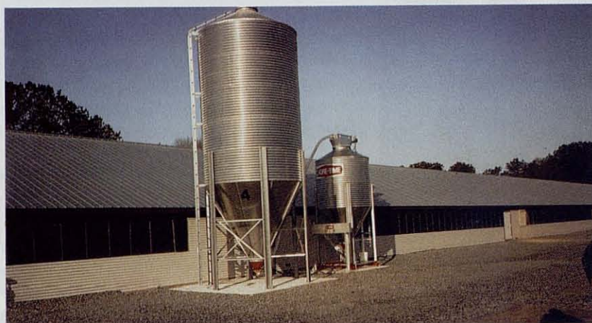
Sistema WEIGH-MATIC ® de Chore-Time, para reproductores pesados, con un silo para almacenaje de pienso y otro sobre una báscula para pesar la ración diaria.
