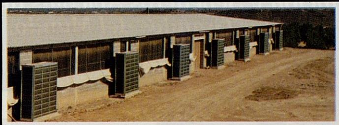
Cabinas de inyección de aire frío para engorde de pollos, gallinas reproductoras, pavos, etc.
