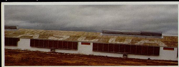
Refrigeración por extracción. Gallinas ponedoras, etc.
