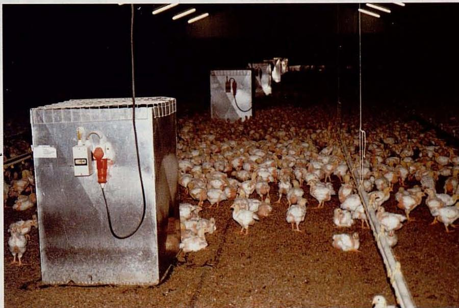
Cajones provistos de un ventilador para proyectar el aire de la nave hacia debajo del piso.
