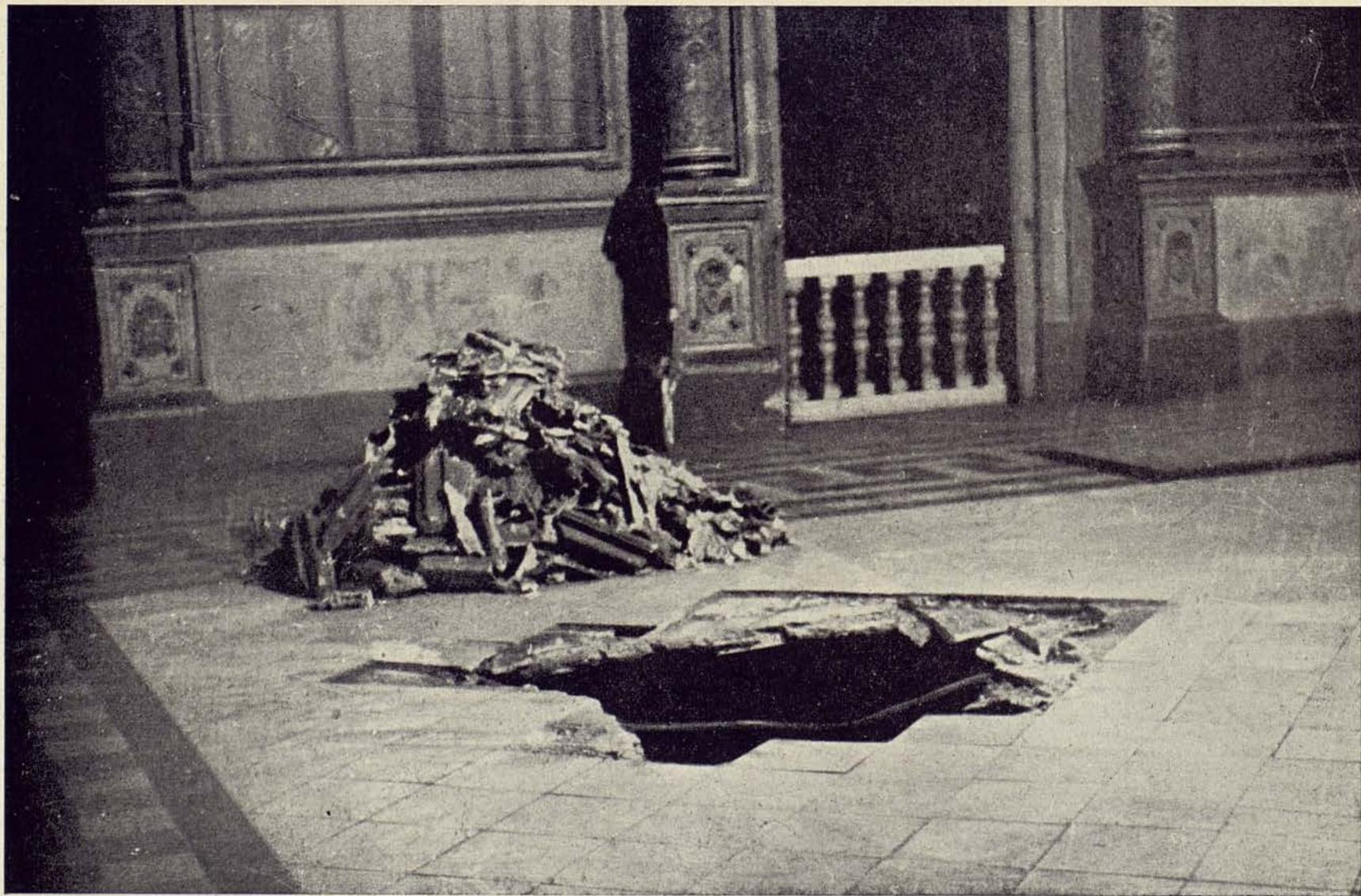
Destrozos causados en el piso del Salón de Descanso por el desprendimiento del techo
