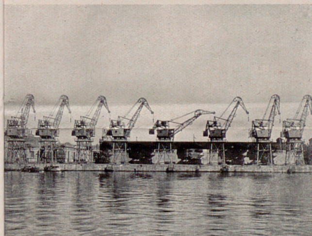
Vista parcial del Port de Barcelona (instal·lació de grues)
