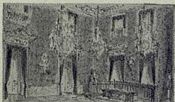
CAMARA OFICIAL DE COMERCIO Y NAVEGACION, Barcelona
