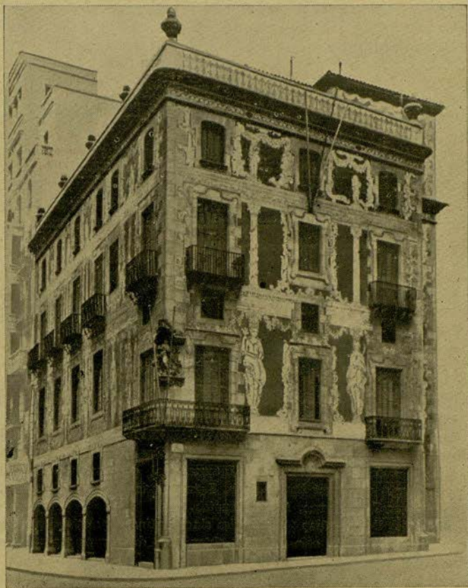
EDIFICIO DEL COLEGIO DEL ARTE MAYOR DE LA SEDA (Siglo XVIII)
