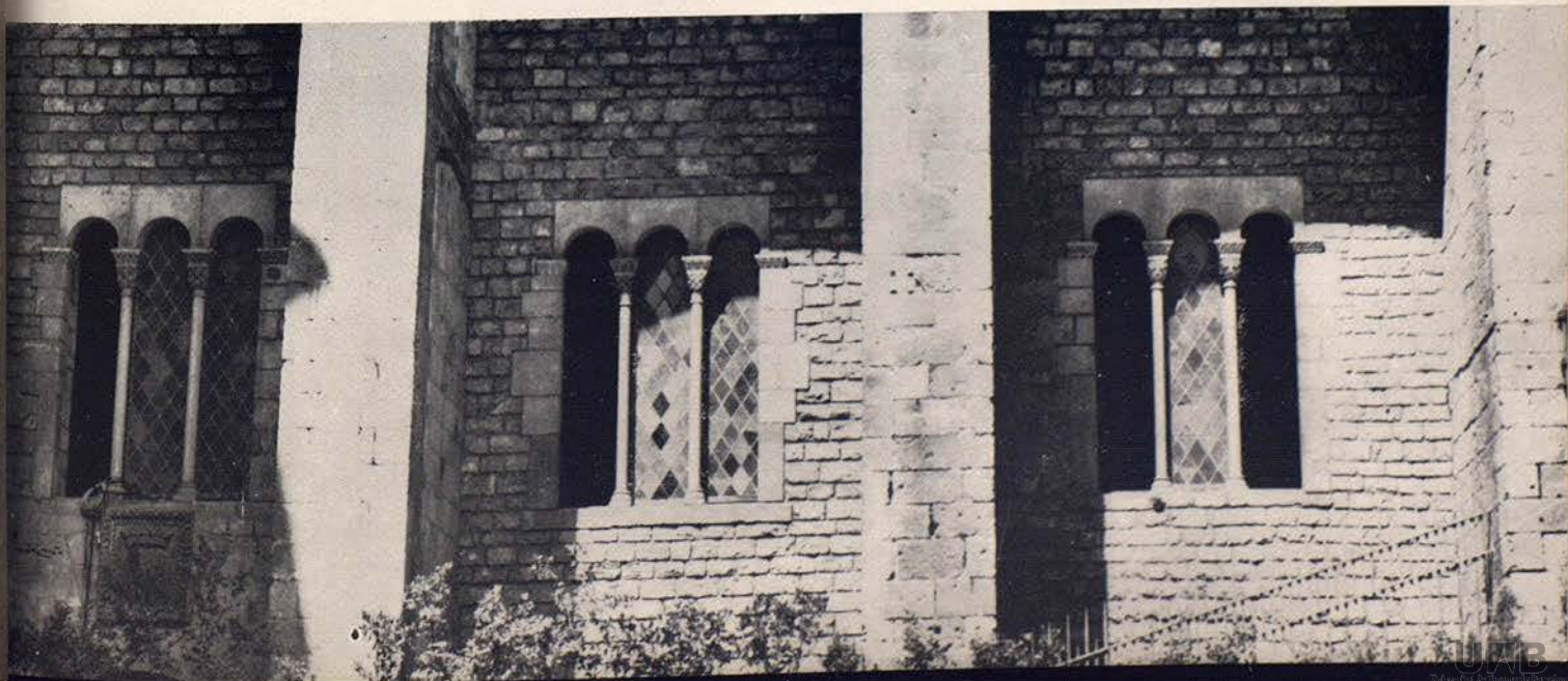
DETALLE EXTERIOR DEL SALÓN DEL TRONO (TINELL)
