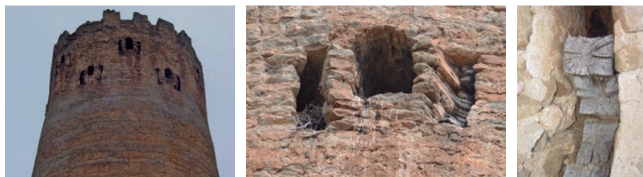
Figura 12. a) Parte superior de la torre donde se ve el doble friso de cadahalsos; b) detalle de unos cadahalsos (J. A. Adell); c) detalle de las maderas aún conservadas de los cadahalsos.
