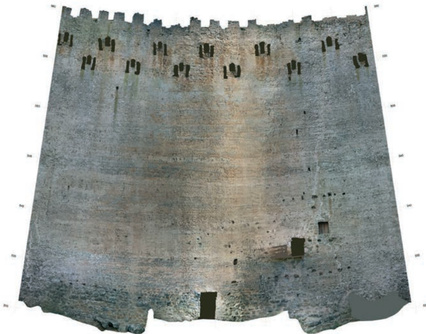
Figura 18. Desarrollo de la cara exterior de la torre (Servei de Patrimoni Arquitectònic de la Generalitat-Global Geomàtica).
