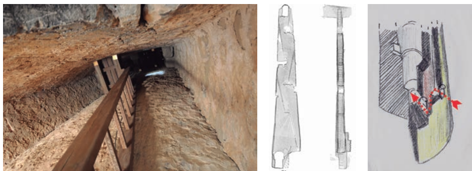
Figura 14. a) buhedera sobre el acceso de la torre; b) escáner láser de la chimenea intramural o buhedera de la torre (Servei de Patrimoni Arquitectònic de la Generalitat-Global Geomàtica); c) esquema de acceso a la torre.
