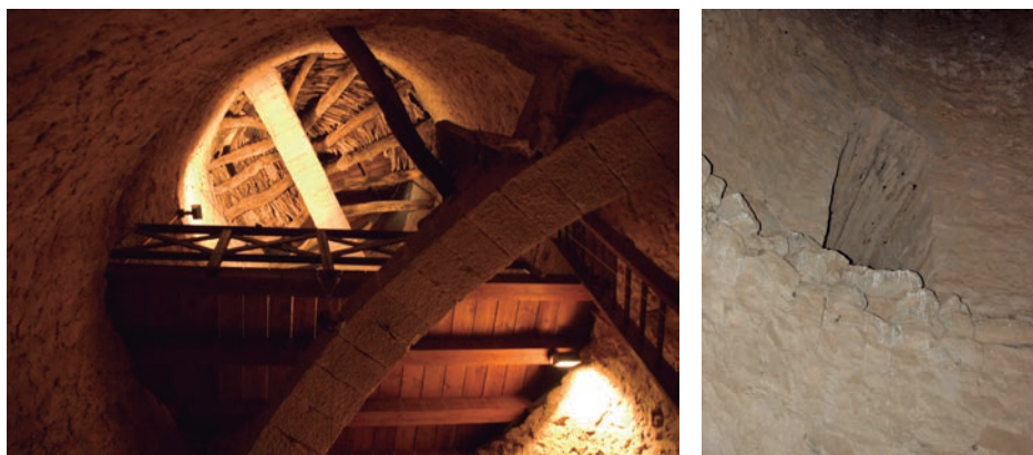
Figura 15. a) interior de la torre; b) armario del primer piso de la torre.
