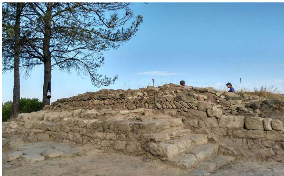
Figura 8. L'escalinata i la plataforma d'accés a l'interior de la torre vistos des del sud.
