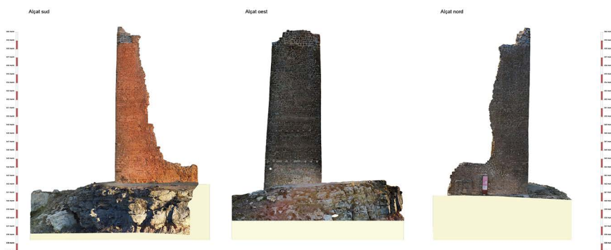
Figura 6. Alçats fotogramètrics de la torre de Peracamps.
