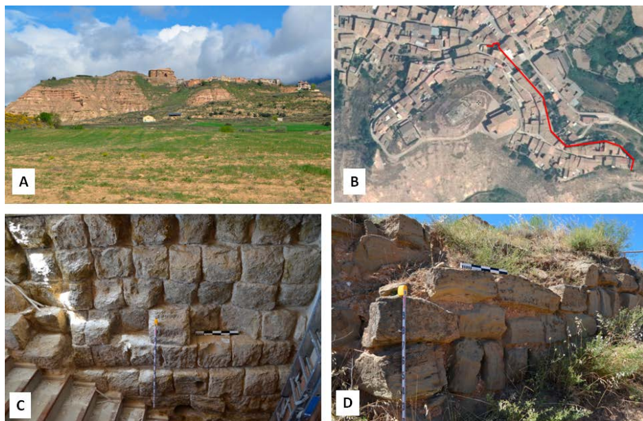
Figura 7. Bolea: vista general (A); imagen aérea (fuente SIGPAC) con indicación del recorrido de la muralla (B); detalle del aparejo de la muralla (C), y detalle del aparejo del reducto defensivo (D).
