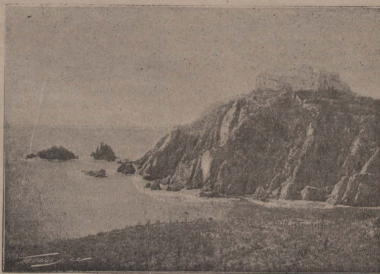
Ruinas del Convent de Blanes
