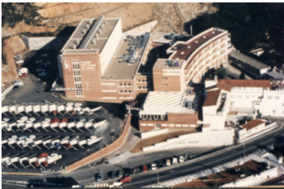
Figura 1. Vista panorámica del Hospital Sant Jaume de Calella.
