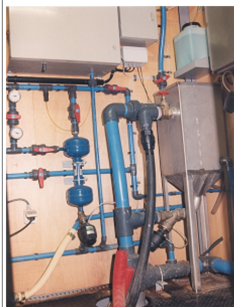
Figura IV.28 Sistema de tractament de l'aigua de riu a les estacions automàtiques d'alerta de la xarxa SAICA, previ a les anàlisis.
