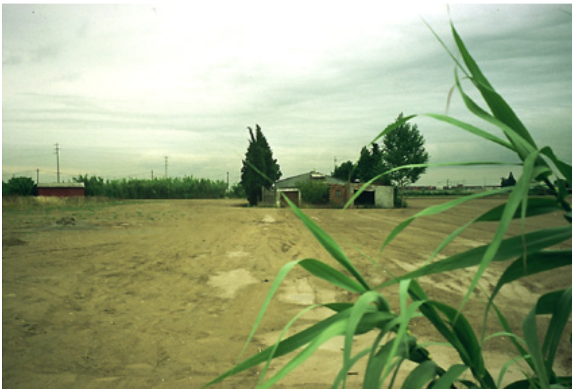
Figura 7.1.- Zonas de extracción-relleno cubiertas de arcillas para impedir la infiltración del agua de lluvia.
