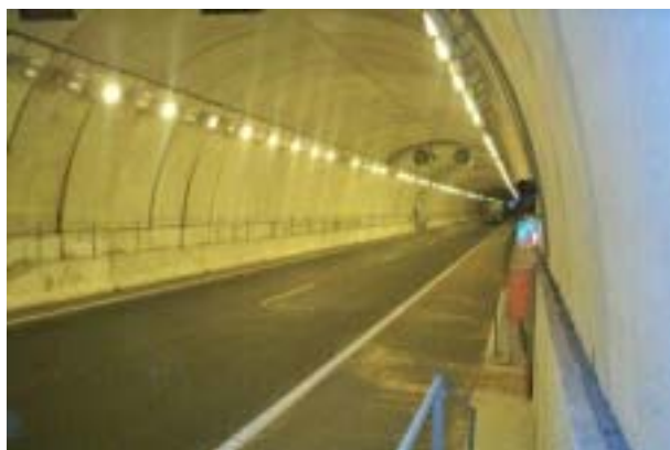
Foto 11: Una imatge d'un túnel com a nou element de la metròpolis.
