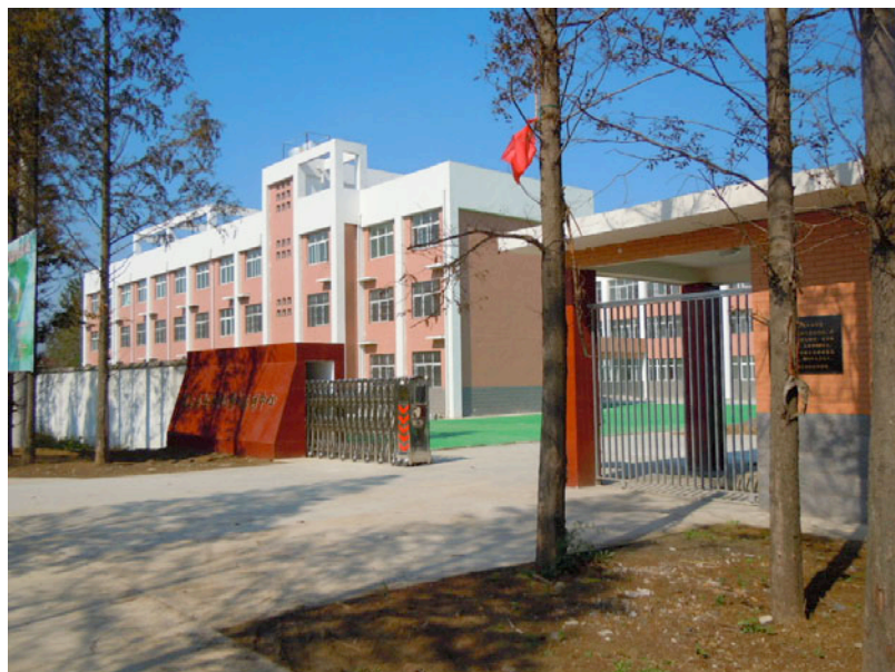
Imagen 47: Edificio que albergará parte de los menores “adoptados” por Wang Jia Yu (diciembre 2011)
