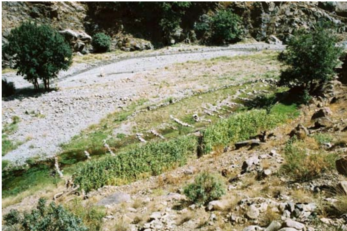
Photo 45 Agdal privé entouré d'un mur en pierres sèches.
