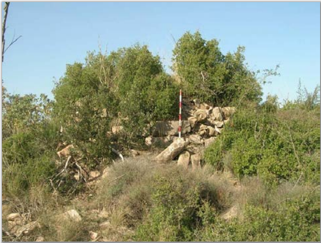
Figura 6: vista de les restes enrunades de la torre del Boixader (Cardona, Bages).
