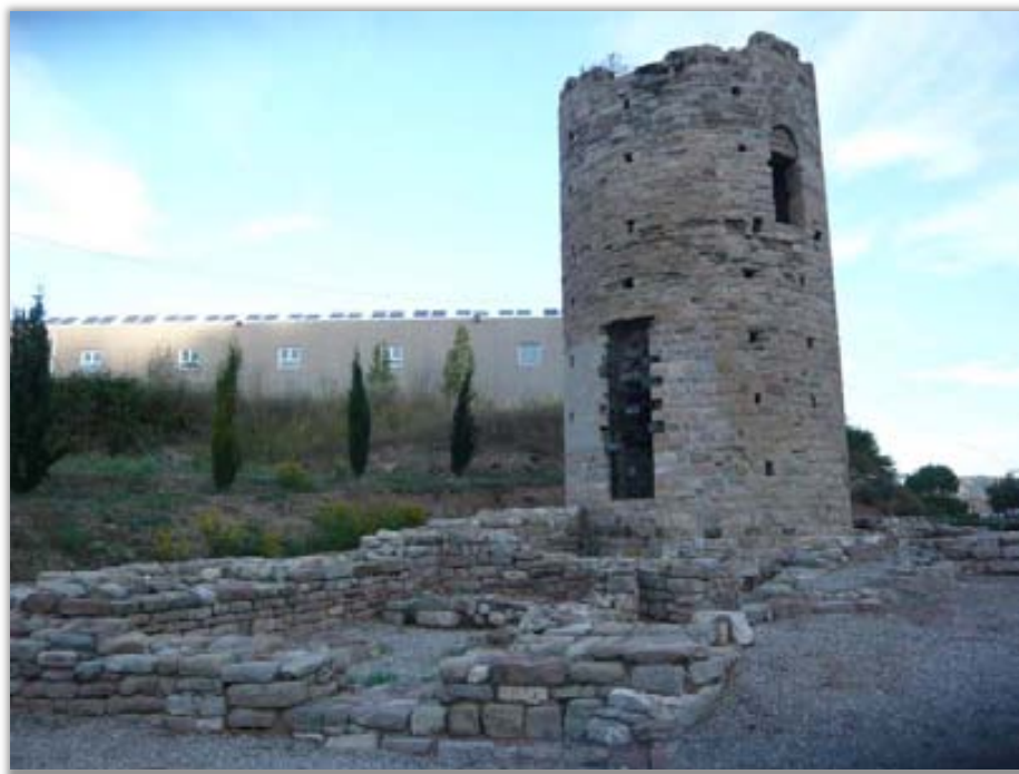
Figura 1: torre de la Pobla o del Fusteret (Súria, Bages) amb les seves estructures adossades.
